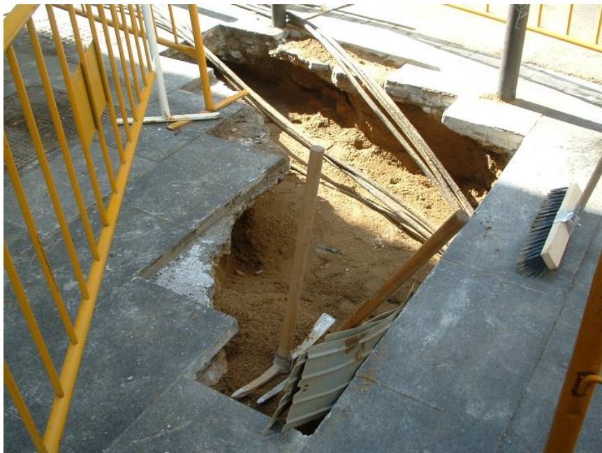
Fotografia 5: Inici de la rasa del carrer Ferlandina en el tram de connexió amb la rasa del carrer Joaquin Costa.
