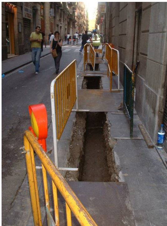
Fotografia 3: Vista general del carrer Joaquin Costa
